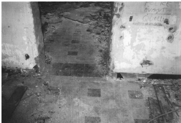
Deux vues de l'intérieur au rez-de-chaussée avant la démolition des bâtiments
