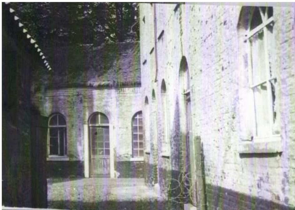
Cette maison est divisée en trois parties , comportant sur le mur sud , pour les deux premières , au rez-de-chaussée , une fenêtre et une porte , au sommet très arrondi et entouré de briques , et à l'étage deux fenêtres à sommet plat reposant sur des appuis plus épais que ceux du rez-de-chaussée .
