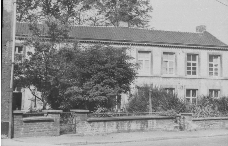
La photo « Anesi 2 » montre la partie droite de la façade est et l'ancien mur de clôture des jardins qui va jusqu'au bout de la parcelle . Ce mur de briques comprend , à certains endroits , des pierres de taille qui ont été réutilisées dans ce mur . Des barrières ferment les ouvertures pratiquées dans ce mur .
