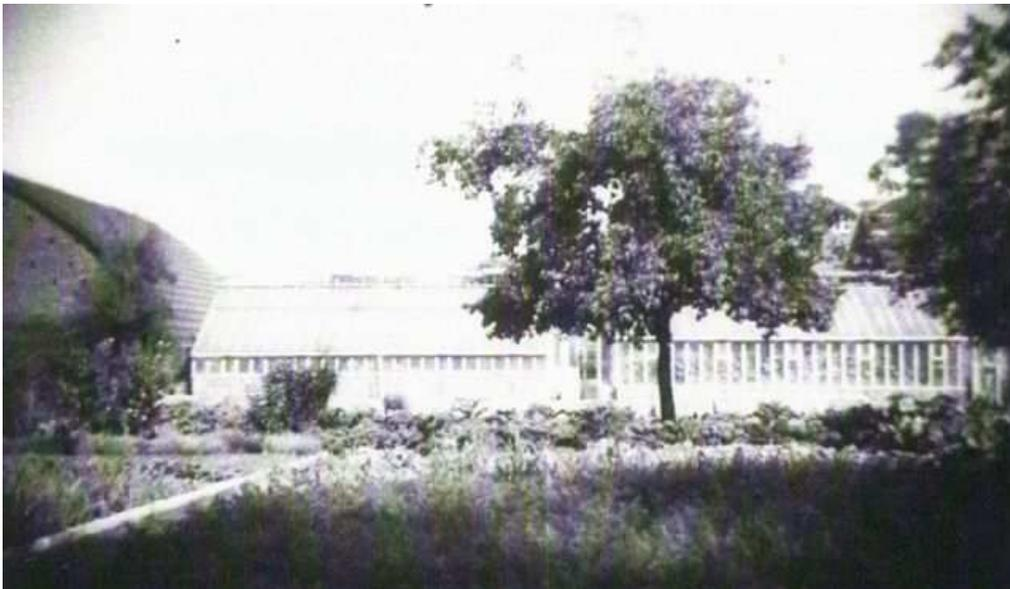
La photo « Serres 3 » montre que la première toiture est en feuilles de zinc soudées en traverses verticales rapprochées deux par deux . Une corniche garnit le devant de la toiture . La deuxième toiture est bitumée , avec une dizaine de lattes de bois verticales qui maintiennent les bandes de papier goudronné . Une corniche récolte aussi les eaux en façade de la serre et une descente d'eau se trouve au centre de cette corniche .
