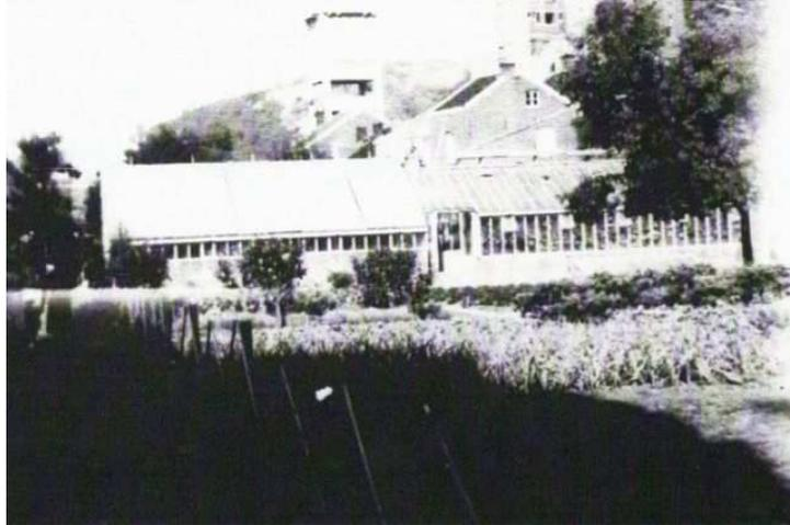
La seconde serre a une toiture identique formée de 26 panneaux vitrés . La base de la serre est formée d'un mur de briques un peu plus haut , surmonté de plus de 26 petites fenêtres basses dont certaines peuvent s'ouvrir . Une petite corniche récolte l'eau de la toiture et une descente d'eau s'ouvre au milieu de celle-ci .
