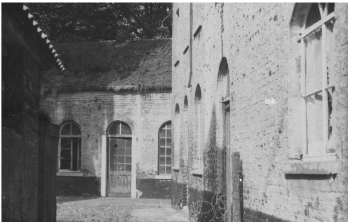
La photo « Forge 2 » nous montre cette vieille forge 792 d ter presque en ruines . La toiture , en double pente orientée est – ouest , est en partie écroulée et envahie de mousses et d’herbes .
