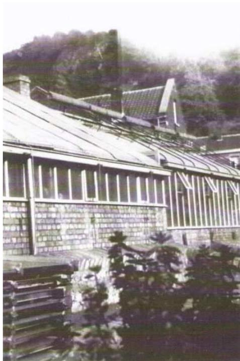
La première serre , un peu plus haute que la seconde , a une toiture vitrée dont la pente est orientée plein sud . Sur une base de briques assez basse et percée de quelques ouvertures , un châssis métallique enserme des hautes et étroites vitres , formant plus ou moins 25 rangées . Cinq de celles-ci sont dotées d'une partie supérieure ouvrante pour aérer l'intérieur de la serre . A l'extrémité ouest , une porte vitrée permet d'y accéder .
