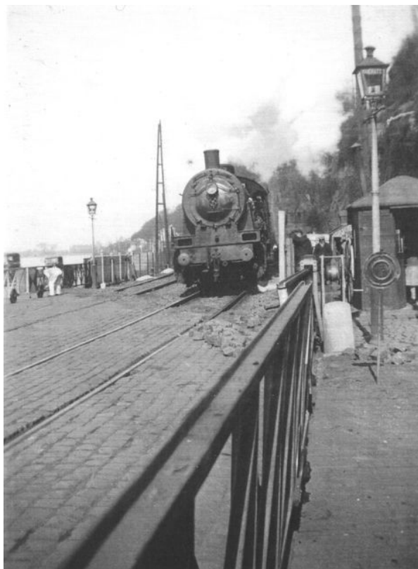
Train au passage à niveau du Sartay
