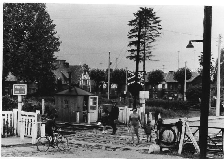
Le passage à niveau et la bawette de la rue des Champs
