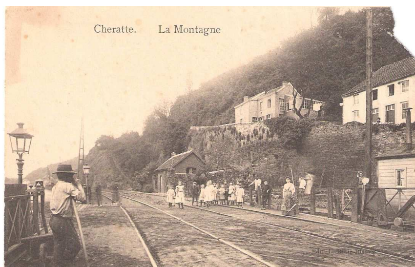
Le passage à niveau du Sartay
