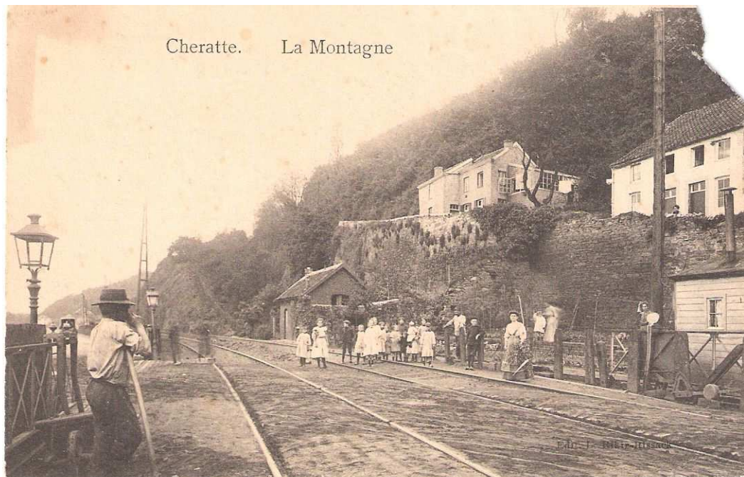
Le passage à niveau du Sartay
