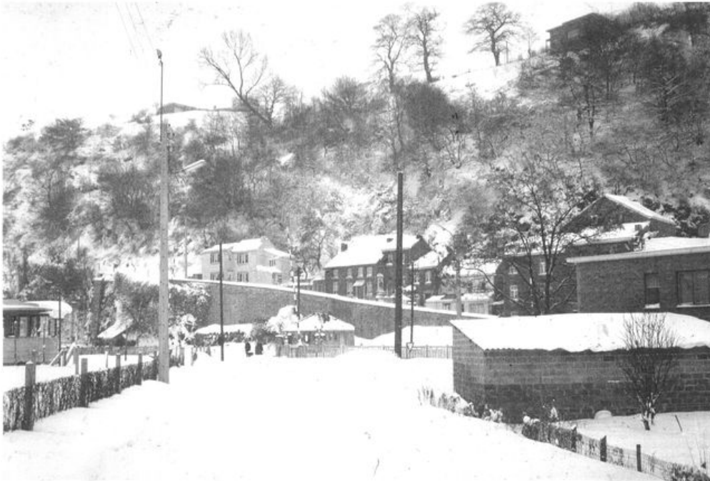
La « bawette » du passage à niveau du Sartay
