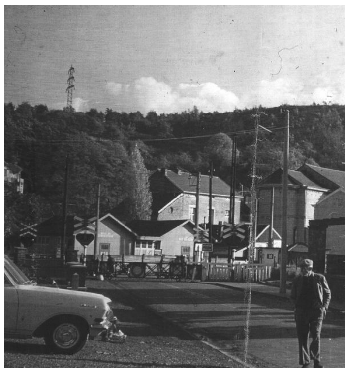
Le passage à niveau de la rue des Champs
