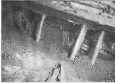
Une haveuse à air comprimé en travail dans la mine.
