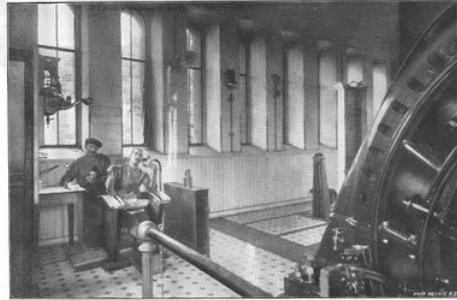
La première machine d'extraction électrique, installée en Belgique au sommet d'une tour (1907, siège de Cheratte, puits n° 1).
