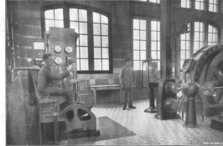
Machine d'extraction électrique sur tour métallique (Cheratte, puits n° 2).
