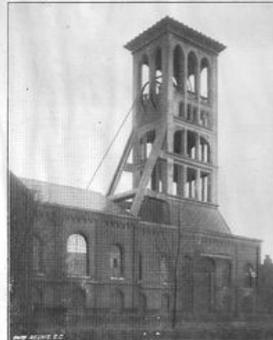
Chassis à molettes en béton armé.
