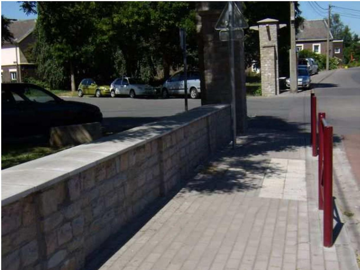
Détail du passage au niveau du trottoir. On peut aussi voir une autre réalisation communale : la réfection du mur d'entrée de la cité : remise en état des maçonneries et sablage.
